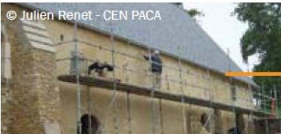
Rénovation de la façade d'un édifice religieux, pose d'un enduit interdisant les échanges entre l'intérieur et l'extérieur de l'ouvrage
