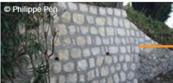
Mur de bord de route rénové, rejointoiement totalement hermétique entre les pierres
