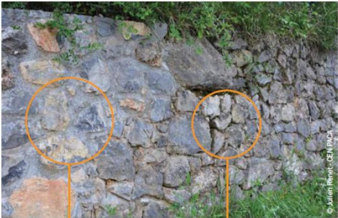
Jointoiment « hermétique » et décapage d'une partie du mur et en pierre : **Rénovation défavorable au Spélépès de Strinati**
